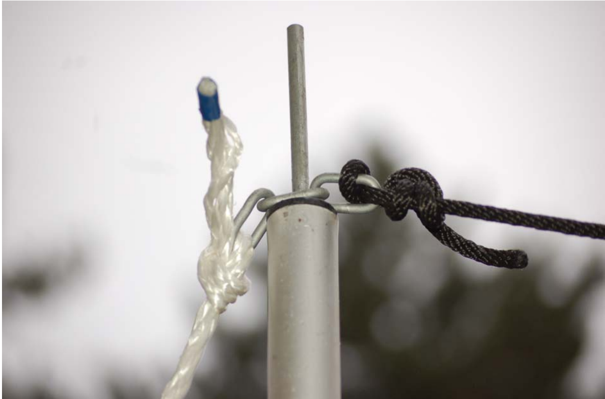
Einsatz von Kettengliedern zur Befestigung der Spannseile
